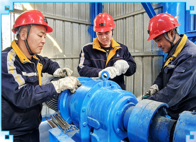
图为凉山矿业员工开展设备检修维护。胡兴荣 摄
